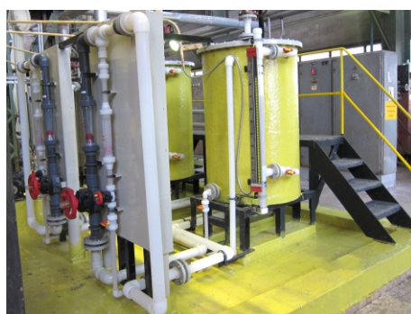
Rezervoar od termoplasta (PVDF-a) obloženom poliesterom i betonska tankvana obložna poliesterom
